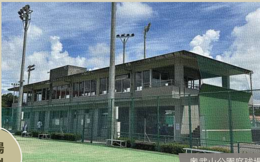
奥武山公園庭球場管理棟
