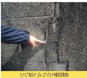
ひび割れなどの外観調査
