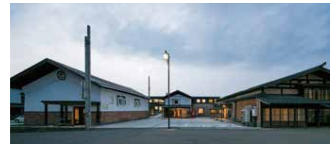
毛馬内酒造改修地域高齢者センター(老人福祉施設へ改修 鹿角市)
