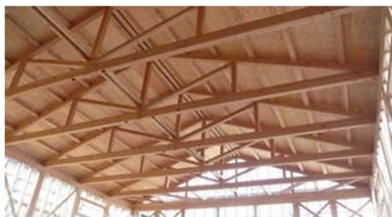
流通製材と住宅用プレカットによる12mスパン山形トラス
